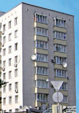
Построен в 1963 г., серия II-18 9 этажей, 1 подъезд, общая S - 2576 кв. м
