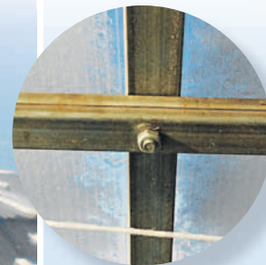
Место крепления поперечной стяжки с цельногнутой опорой.
