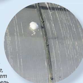
Место соединения поперечных стяжек. Аккуратно стыкуются и стягиваются болтом.
