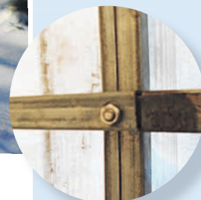
Место соединения поперечных стяжек. Аккуратно стыкуются и стягиваются болтом.
