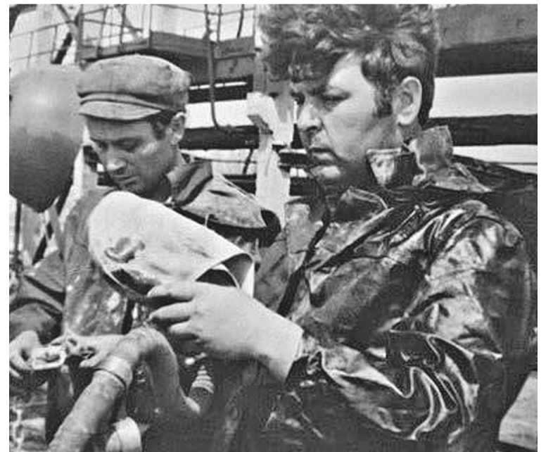
Иосиф Душанек на строительстве ПК «Шесхарис».
