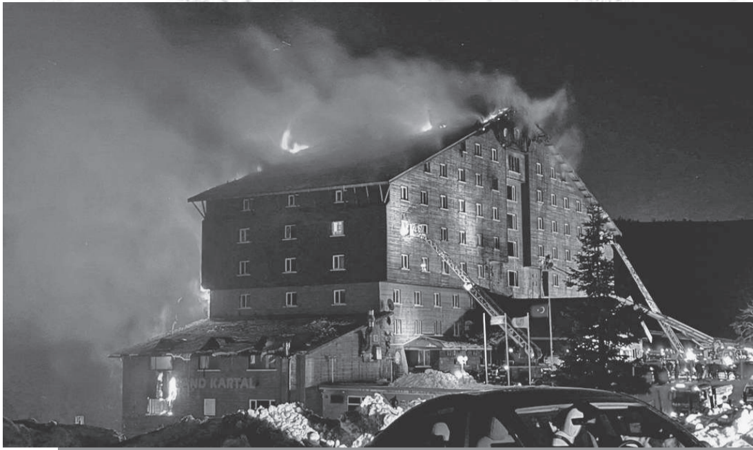
Облицованный деревом горный отель вспыхнул факелом. Сигнализация не сработала, автоматической системы пожаротушения в гостинице вообще не оказалось. Лестницы спасателей не доставали до верхних этажей, где люди оказались в огненной ловушке.
