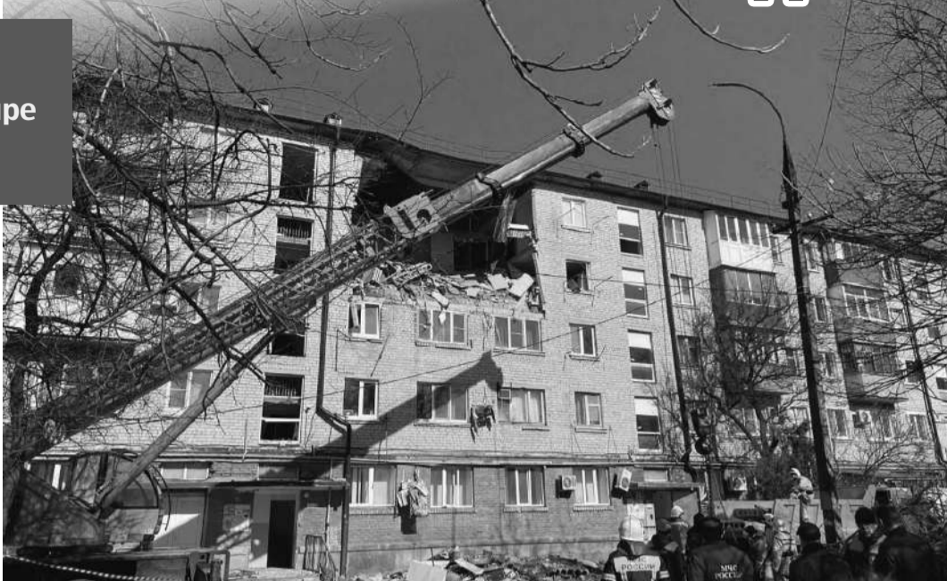
Взрывом разнесло квартиры на четвертом и пятом этажах.
