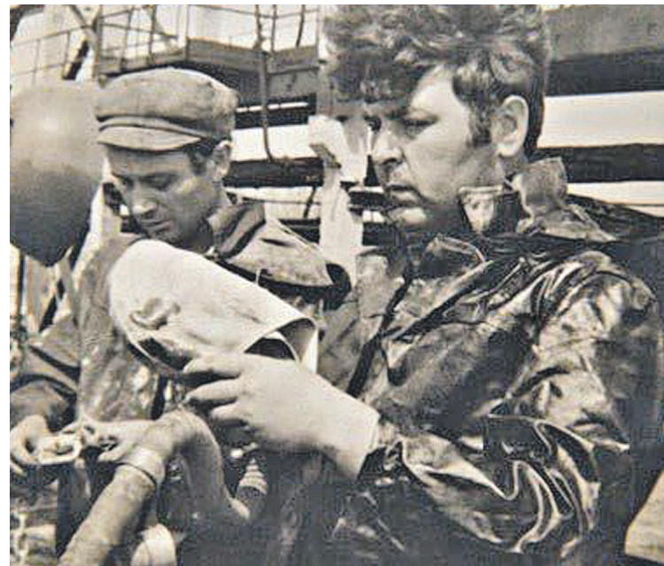
Иосиф Душанек на строительстве ПК «Шесхарис».
