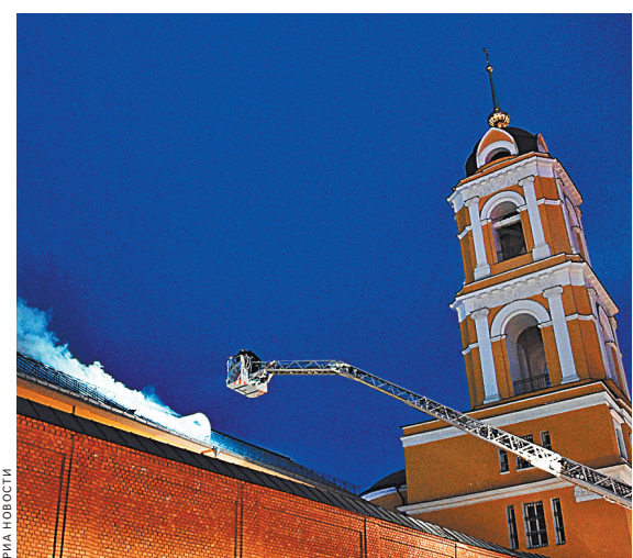
По предварительным данным, причиной возгорания стали проводимые в монастыре строительные работы.
