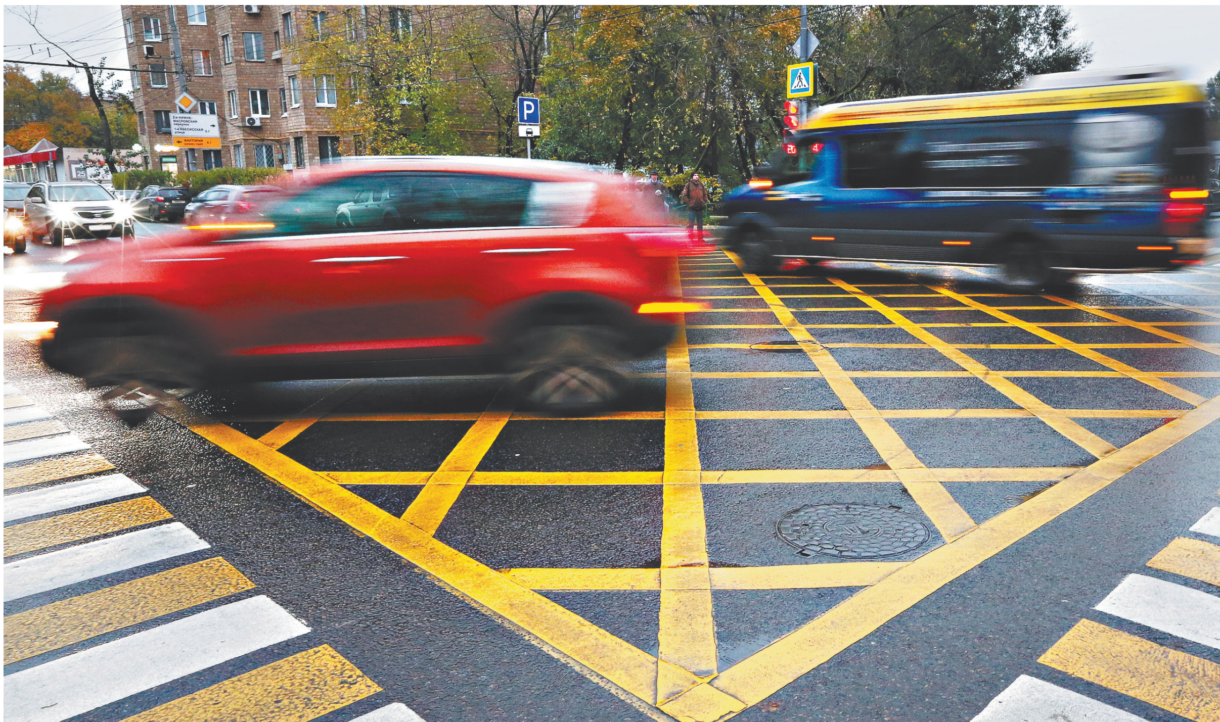
Мокрая дорога таит в себе много опасностей, особенно при такой разметке. На этом пластике, смоченном водой, машину может занести, а эффективность тормозов и вовсе приближается к нулевой.
