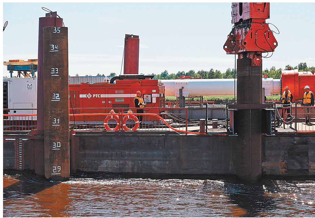
В основание моста через реку Обь вбили первые сваи. Через 3,5 года по нему должны проехать первые машины.
