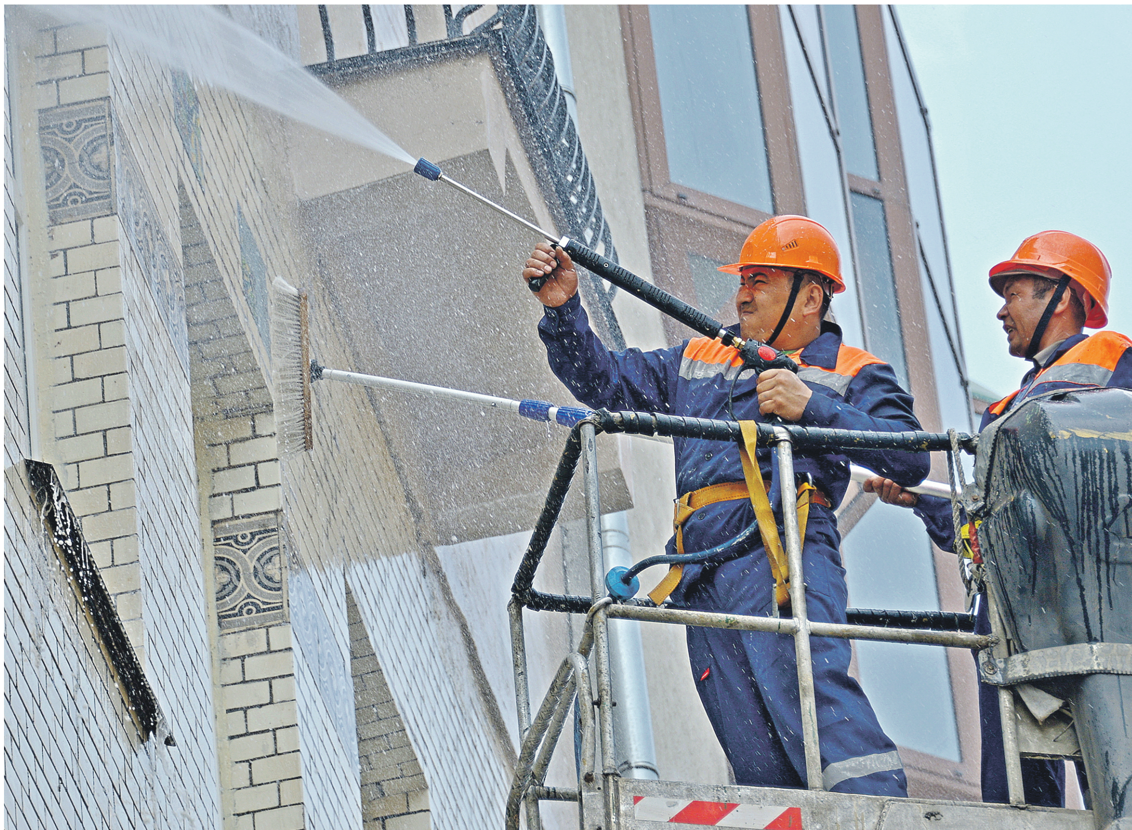
24 апреля. Сотрудники ГБУ «Жилищник района Тверской» Джомард Исмаилов (слева) и Биксултан Акалов отмывают фасад дома № 17 на Тверской улице. Эти работы по уходу за домом входят в обязанности управляющей компании
