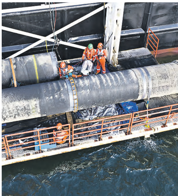
Специалисты проводят надводную сварку захлестного стыка газопровода «Северный поток — 2»
